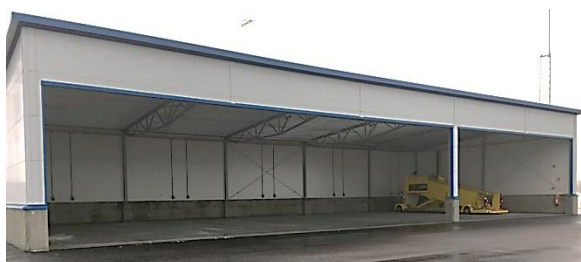
Skärmtak med uppställningsplatser för trappor på ramp D/E
