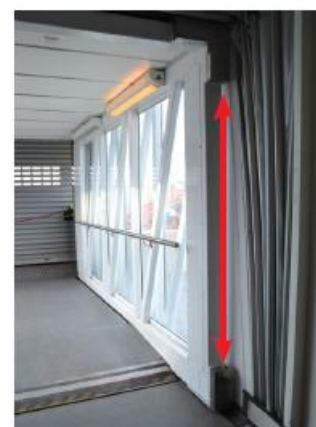
Klämskydd i tunnel
