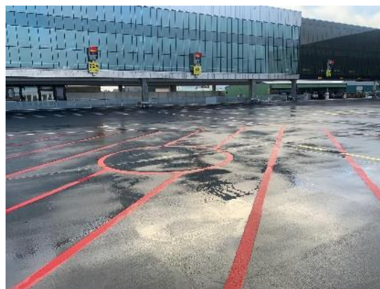
Vid dockning av kod D eller E-flygplan på stand 21/22/23 kan bryggan parkeras i ett stand-by läge närmare stopplinje
