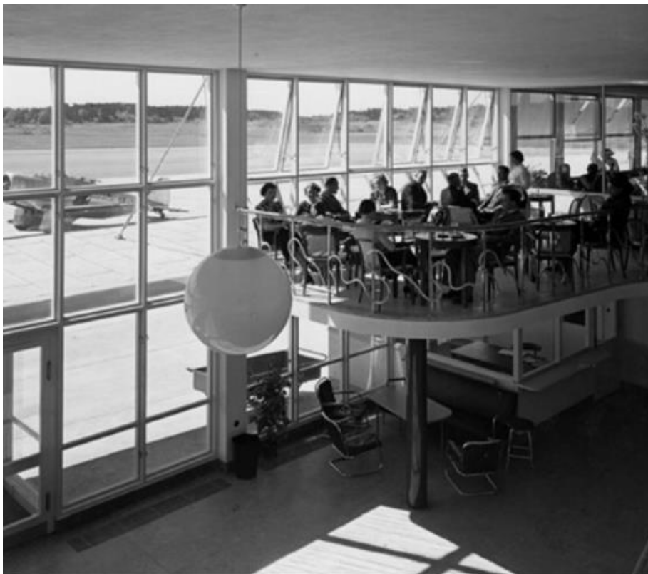
Interiör från kaféet/restaurangen i stationsbyggnaden.
