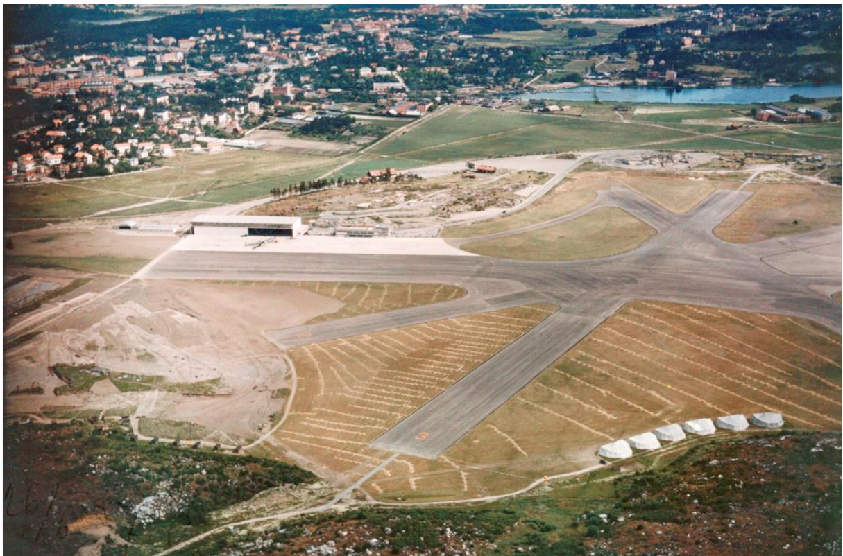
Stationsbyggnaden och Hangar A från luften i nordöstlig riktning..
