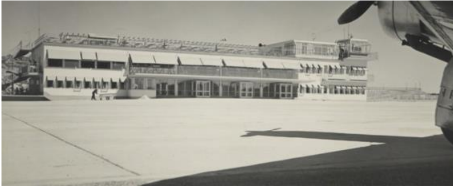
Stationsbyggnaden från airside, troligen sent 1930-tal. Här syns dåvarande utformning med terrass för allmänheten, flygledartornet i sydväst, samt bottenplanets tre gater i trä/glas som senare byggts samman till en enhetlig fasad under skärmtakets hela längd.
