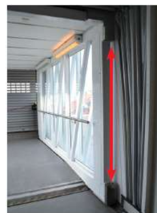
Klämskydd i tunnel
